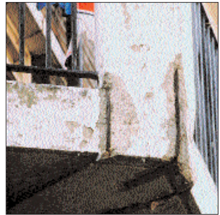
Spalling
